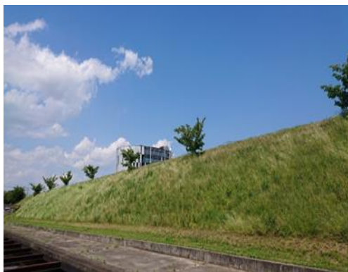
▼会社裏の土手（作業前）
