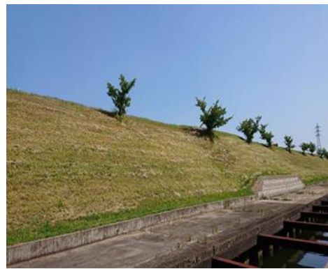
▼会社裏の土手（作業後）
