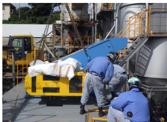
破碎機工事の様子
