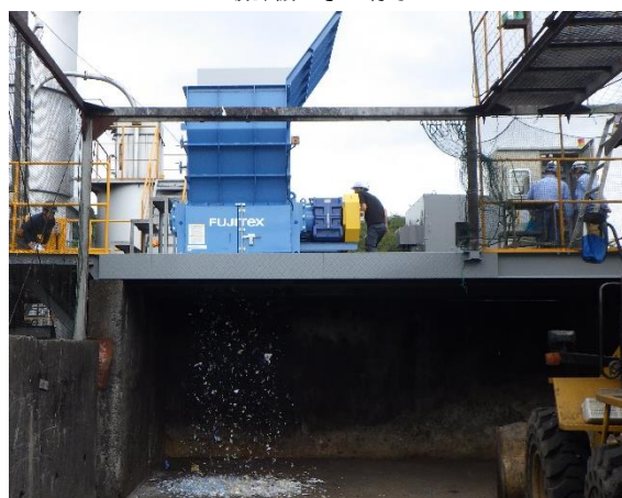
破碎機試運転の様子
