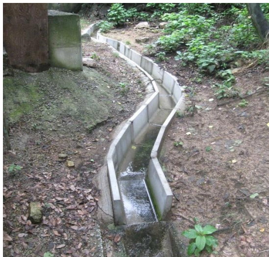
側溝設置の様子
