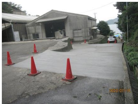
工事完了後の状況
