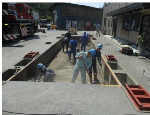
トラックスケールの清掃
