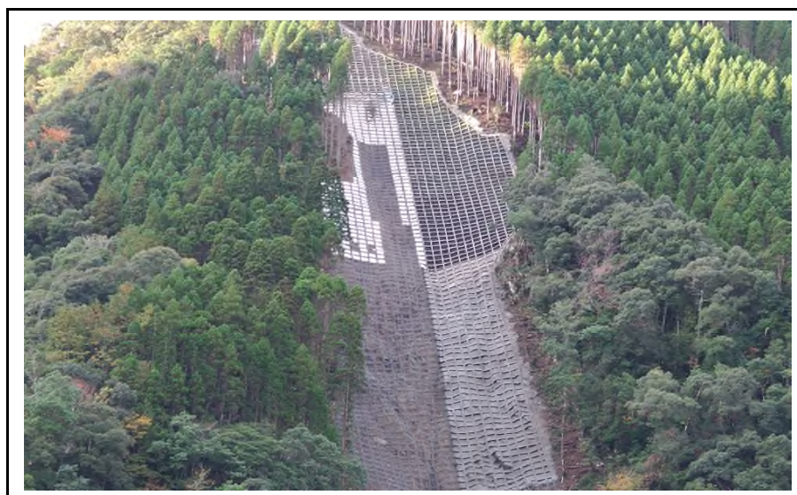
当社施工現場
