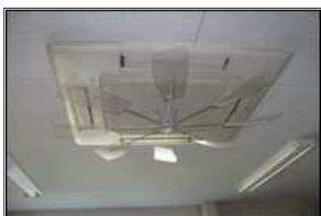
工場・倉庫にLEDライト設置
