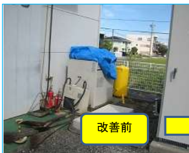
屋外コンプレッサ出口のエアホースからエアの漏れ ※エアホースの交換
