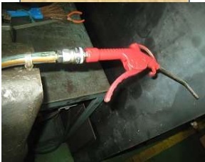
エアホースからの エア漏れ修理
