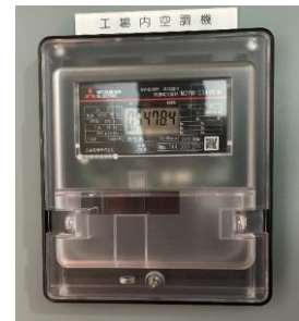
電力使用量の見える化3ヶ年計画 電力量計の設置('24.2)
