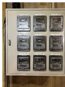
電力使用量の見える化3ヶ年計画 電力量計の設置('24.2)
