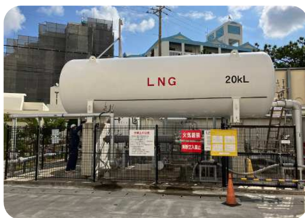
LNGタンク定期検査①
