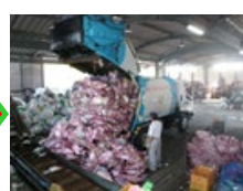
中間処理工場
