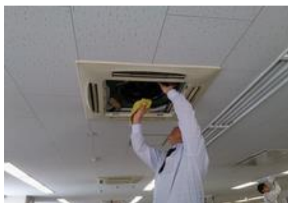
エアコンフィルターの清掃 (札幌)
