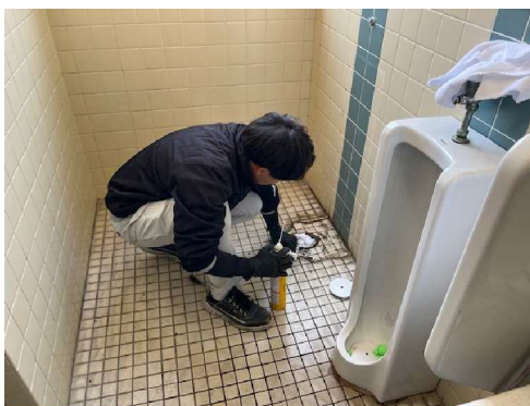
小便器取替作業状況
