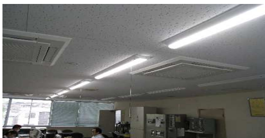
LED蛍光灯の間引き、スイッチ取付
