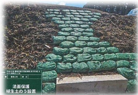
構造物設置箇所、進入路の法面崩壊防止対策（土のう設置）
