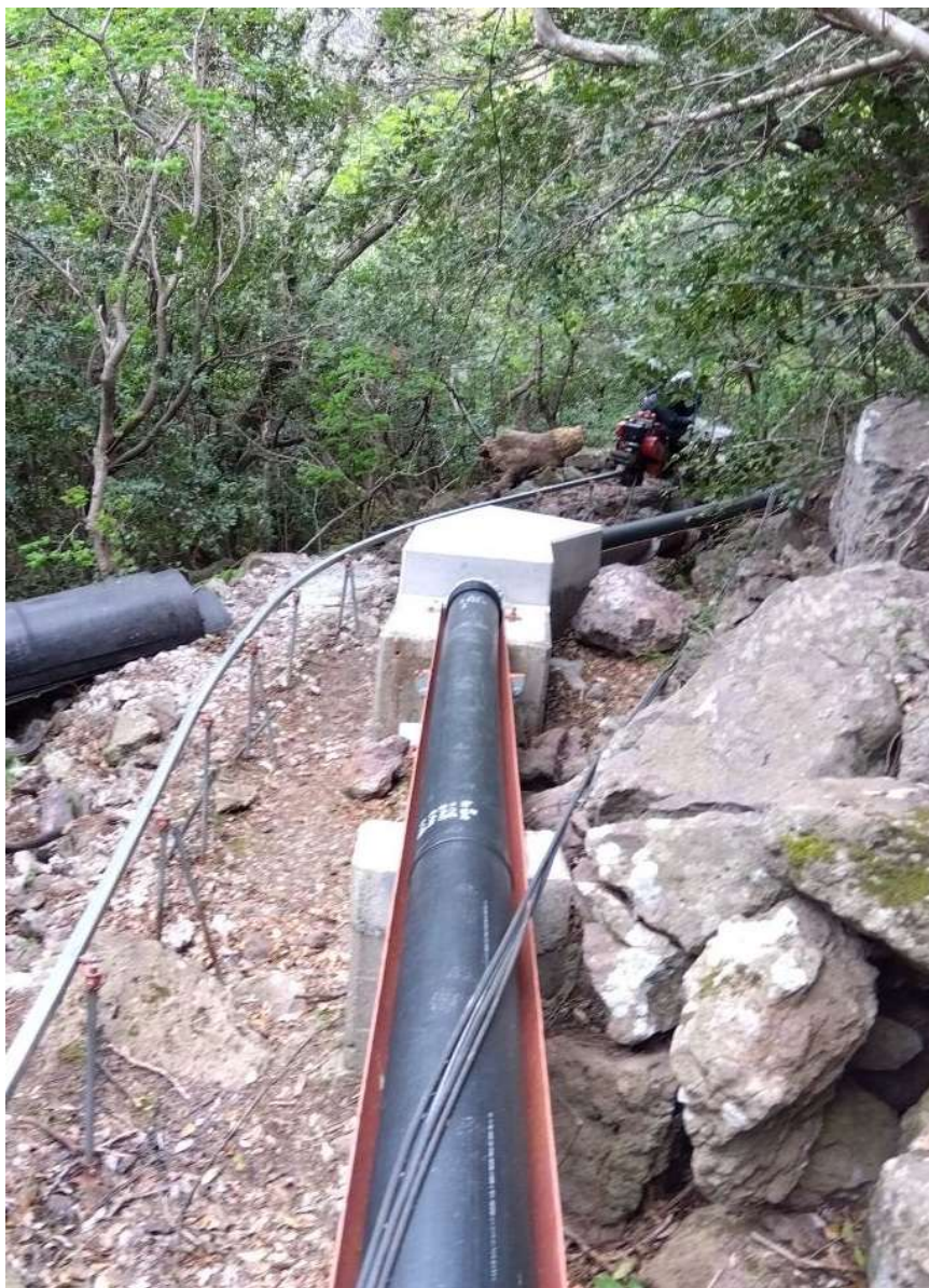
島根県隠岐の島 油井発電所配管入替他工事 流入管部 (199Kw、発電事業者(株)鴻池組)
