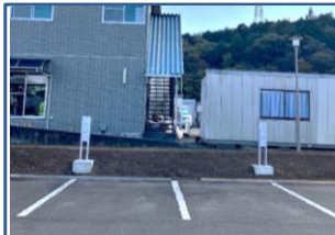
充電設備の設置
