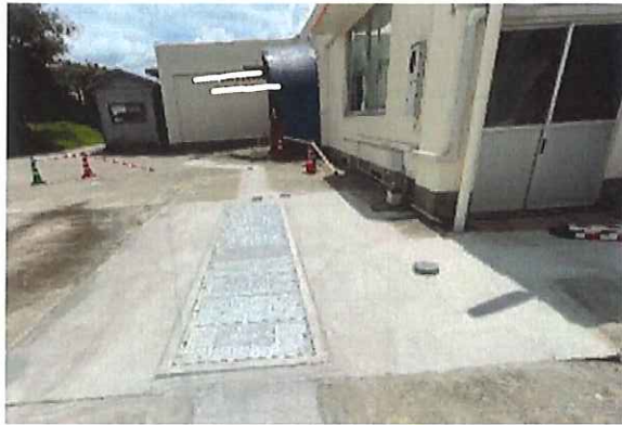
～合併浄化槽への入替工事～
