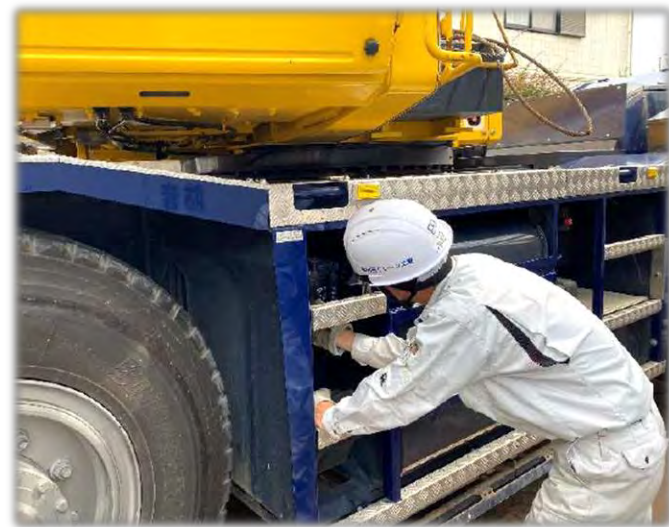
工事用機械点検・整備の実施
