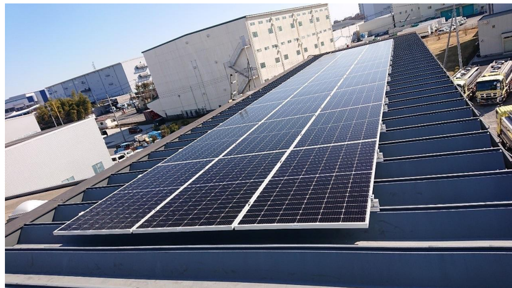
立体倉庫側(南側屋根上)
