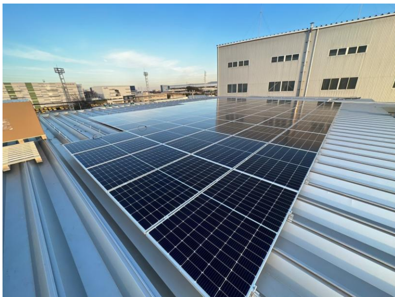
新棟側(北側屋根上)
