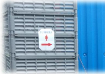
▲女性用仮設便所の設置
