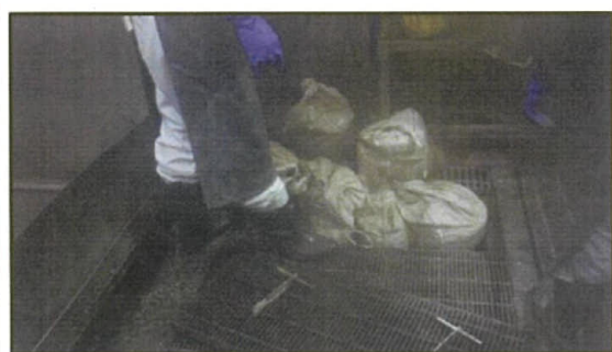
【「グレーチング」の下の排水箇所に土嚢置く】
