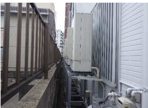
室外機点検時①
