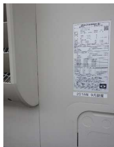
室外機点検時②
