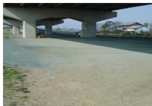
②国道1号(バイパス)高架下多目的広場国道1号(バ
