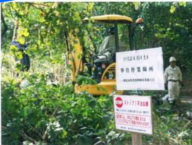
不法投棄物撤去作業
