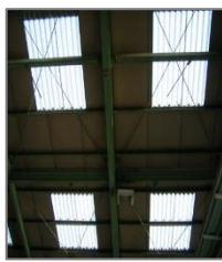
(工場内の天窓)
