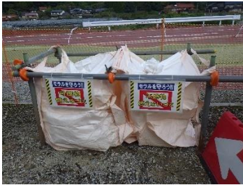
伊万里畑川内蔵木線 建設現場でのゴミ分別
