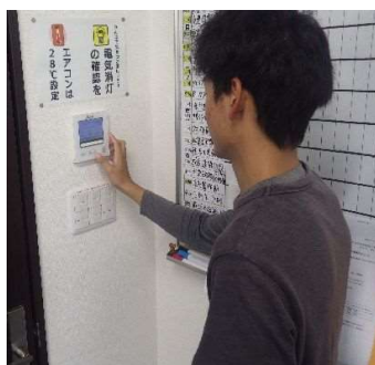
エアコンの設定状況
