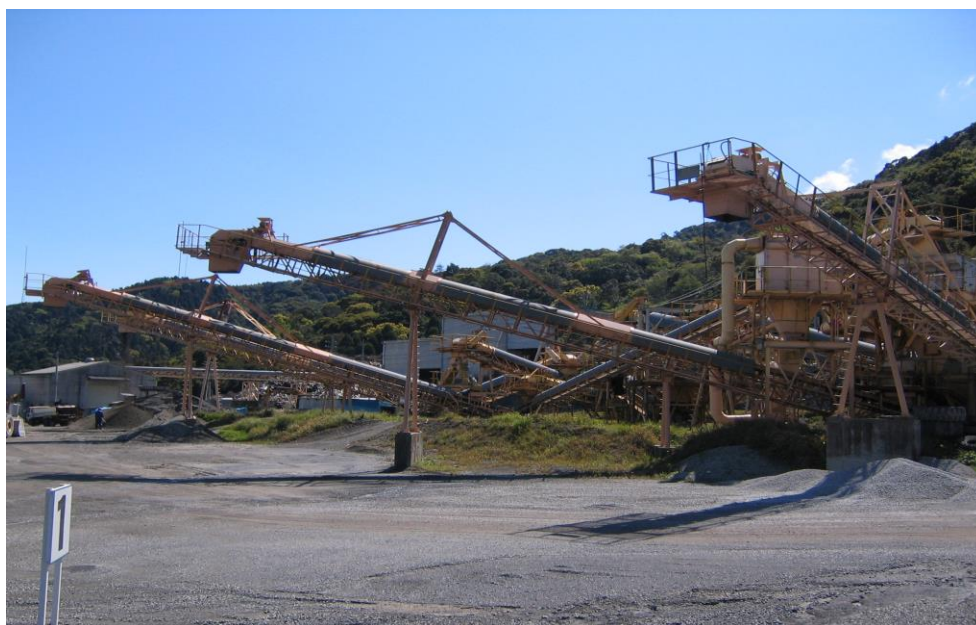
コンクリート破砕プラント
