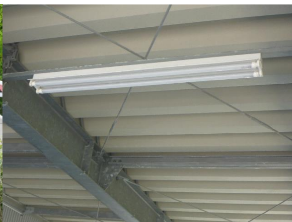
LED 照明器具例
