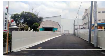
八尾新工場(令和3年7月オープン)
