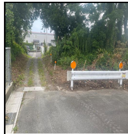
南東道路作業終了
