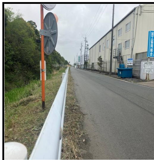
屋島川作業終了
