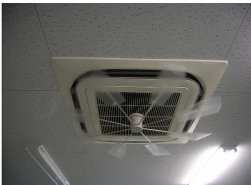
エアコンの吹き出し口にファンを設置。エアコンの風を利用し空気を循環させ、エアコンを効率的に使用している。
