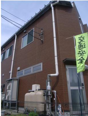
雨水タンクを利用し、トイレの水は雨水を利用する。
