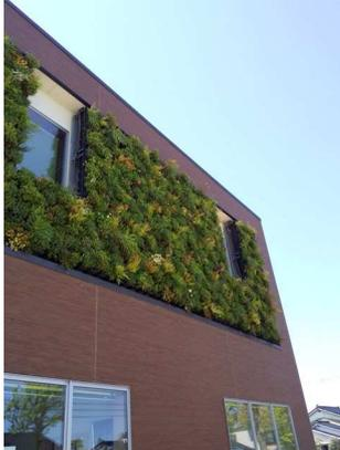
社屋の南面、東面、北面に、壁面緑化を設置し、夏場は自動灌水装置により全面に灌水を行う。
