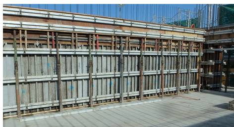
アルミ製コンクリート型枠(併用)
