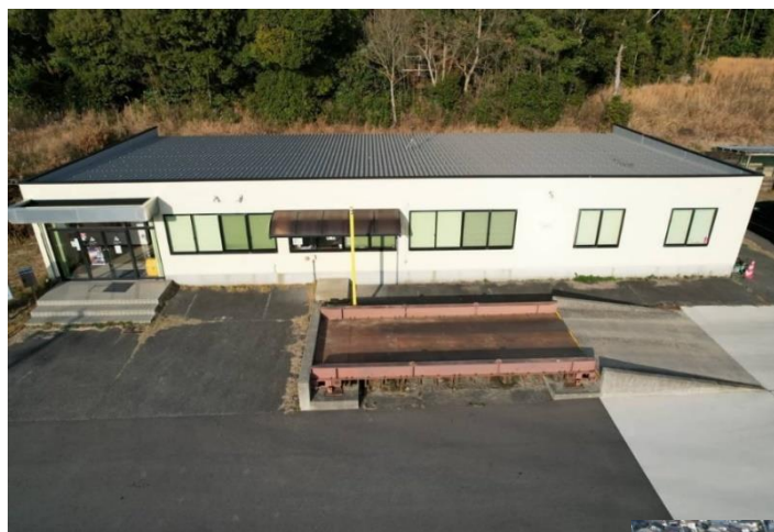
R3年10月 アスファルト・コンクリート舗装工事実施
