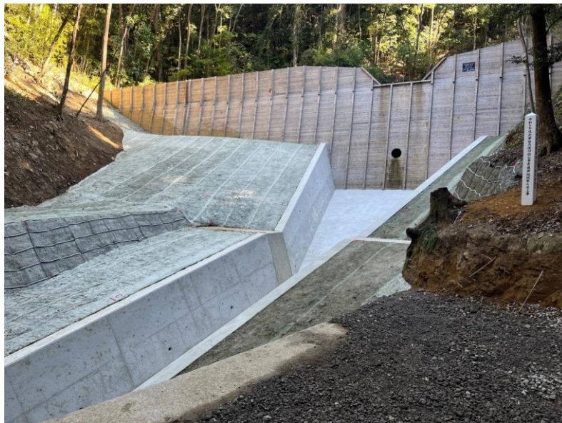
(天草市御所浦町唐木崎現場)
