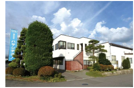
本社・第一工場
