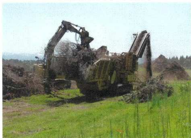
移動式破碎状況
