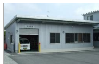
本社 土質試験室棟
