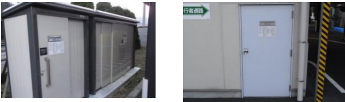
神奈川事業所 防災用備品置場の一部
