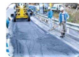
焼却炉路盤材再資源化
