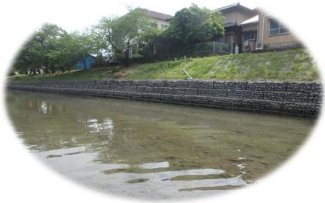
令和5年度勝間田川護岸工事
