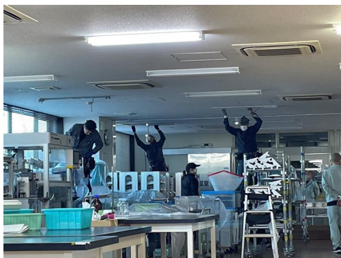
LED化工事の様子
