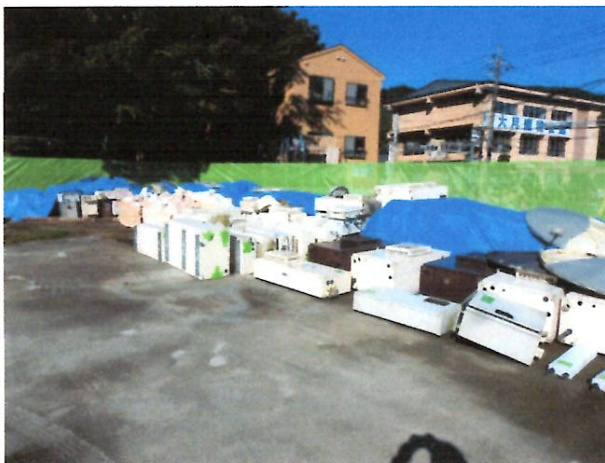
撤去した機器類
