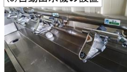
(5)自動出水機の設置
