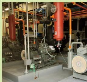
自然冷媒(NH₃(アンモニア)とCO₂(二酸化炭素))を使用した冷凍機
