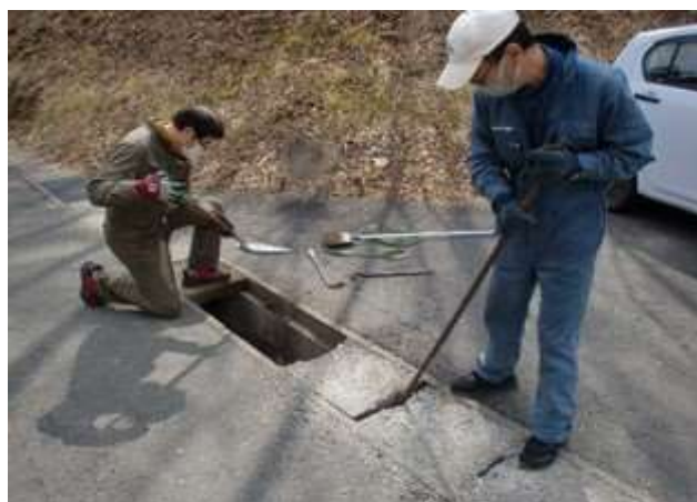
岩手工場： 会社駐車場側溝蓋の交換
