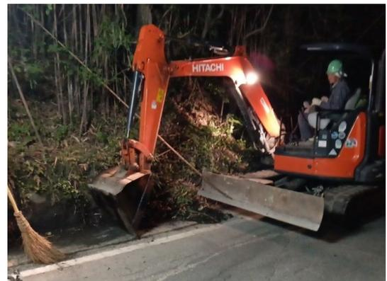
☆法面が流れガードレールが倒壊していた為、復旧を行った（菊池鹿北線：R6.1）
