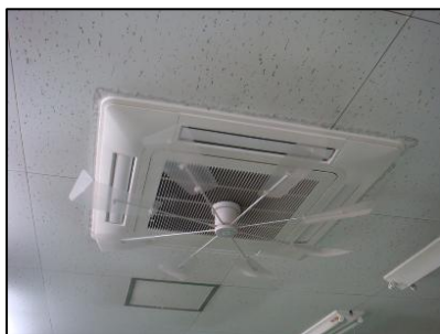
エアコン省エネ機器取付①
