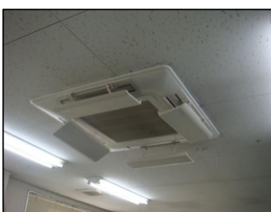
エアコン省エネ機器取付②
