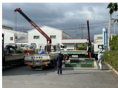
トラックスケール計量点検実施しました
