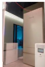
蓄電池ユニット
