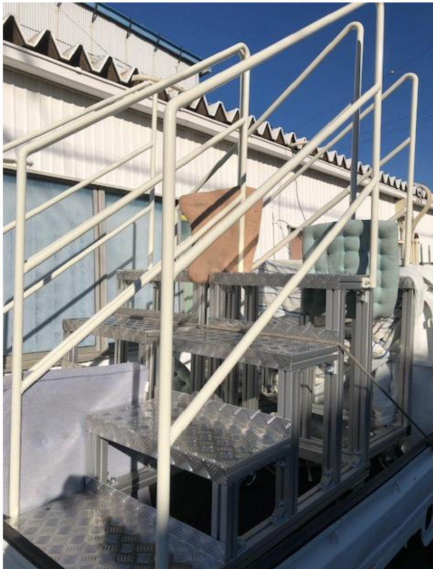
トラック荷台への昇降踏台（転倒・落下対策）
